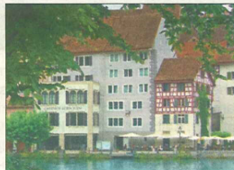
Der Gasthof Hirschen ist Teil der Altstadthäuserzeile am Rhein.
